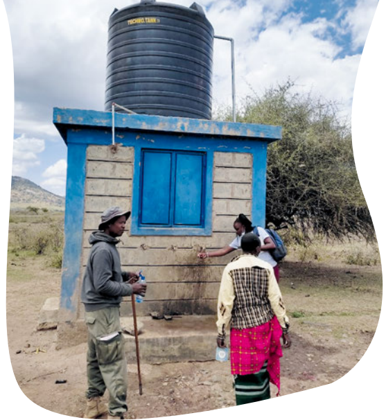
Einer von insgesamt 17 Wasserkiosken und Wassertanks in Baawa/Kenia
